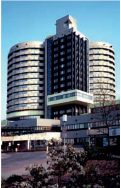
Sanierung/Umbau des Universitätsklinikum Münster.
