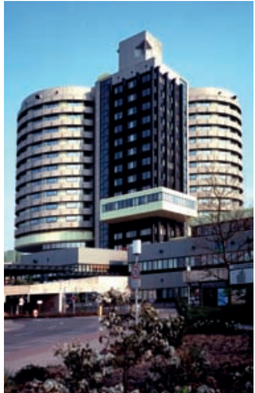
Sanierung/Umbau des Universitätsklinikum Münster.
